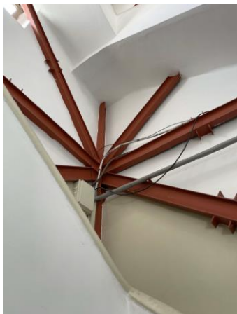
Figura 10 – Struttura metallica di rinforzo sul torrione lato nord
