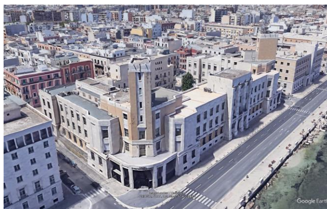
Figura 2– Vista lato est
